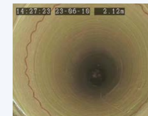
Buisrehabilitatie voor en na
