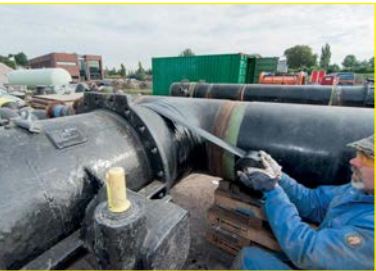
Aanbrengen POLYKEN tape.
