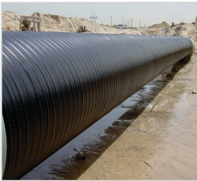
Buisrehabilitatie: voor en na
