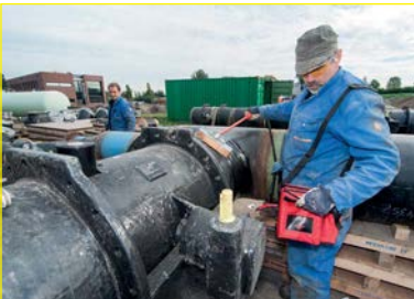
Bekleding testen op o.a. luchtbellen met een afvonkapparaat.
